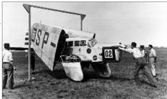
PZL-19 podczas próby technicznej po złożeniu skrzydeł
